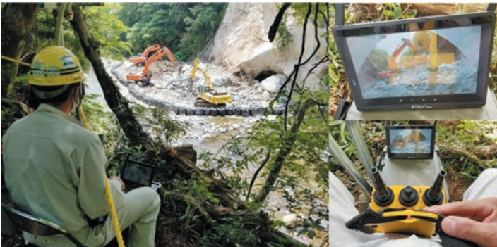
↑無人化施工（名取川災害復旧工事）
