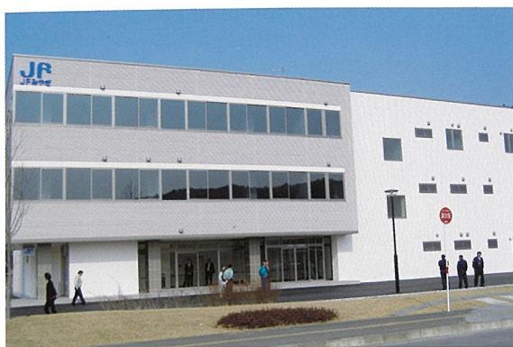
宮城県水産会館
