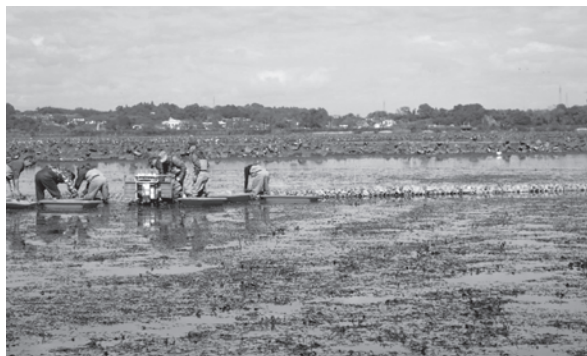
▲エコトーン造成作業の様子
