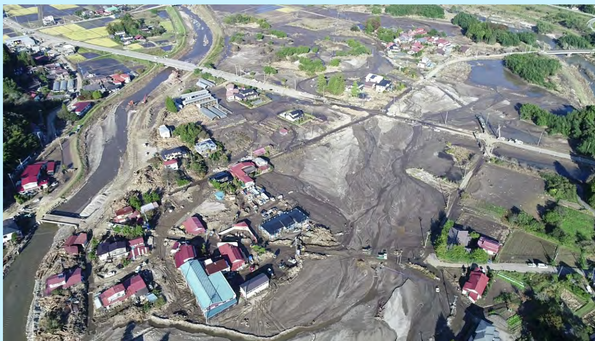
令和元年東日本台風（丸森町）
