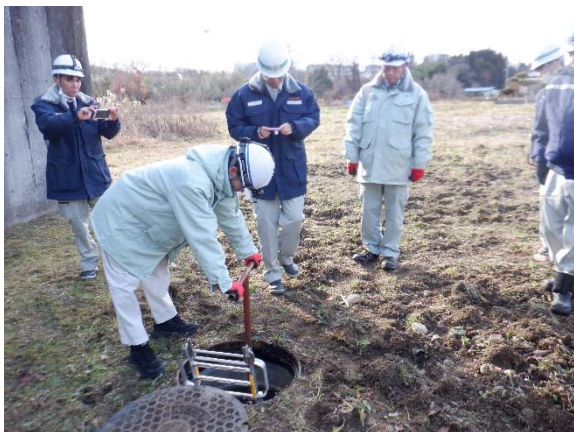
バルブ開閉作業確認
