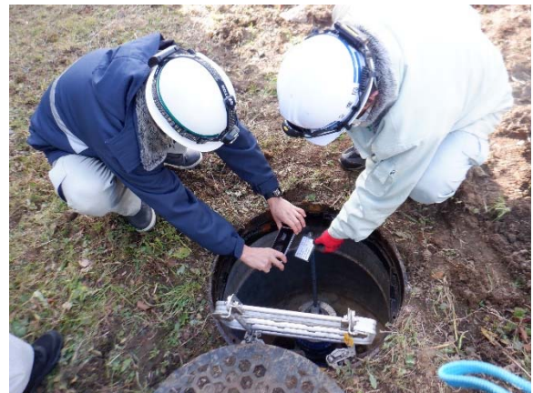
マンホール内バルブ確認
