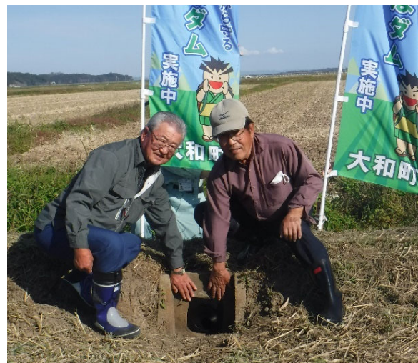
田んぼ排水口への堰板設置
