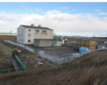
志田谷地排水機場
