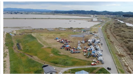
水防拠点の整備
