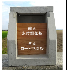
ロー型堰板設置状況
