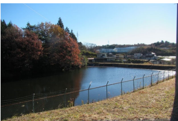
農業用ため池
