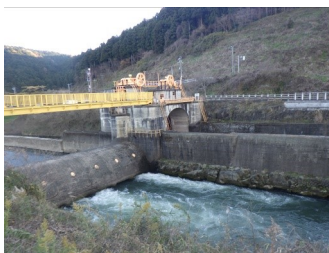
脇谷洗堰と脇谷閘門
