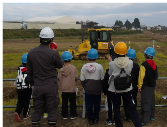
自動制御されたブルドーザーの実演
