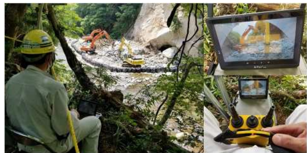
↑無人化施工(名取川災害復旧工事)
