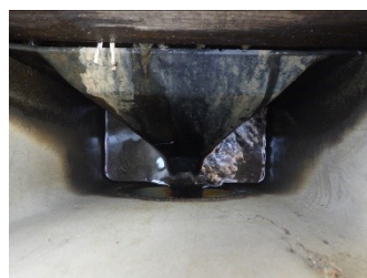
ロート型堰板設置状況
