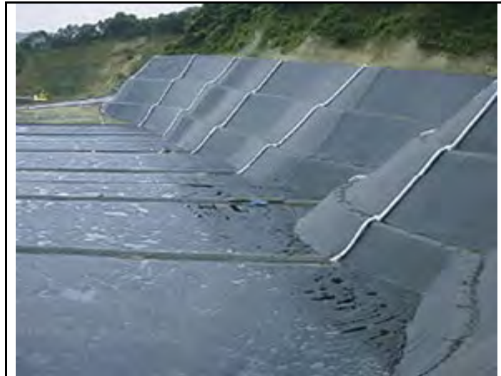
遮水シート施工後の状況
