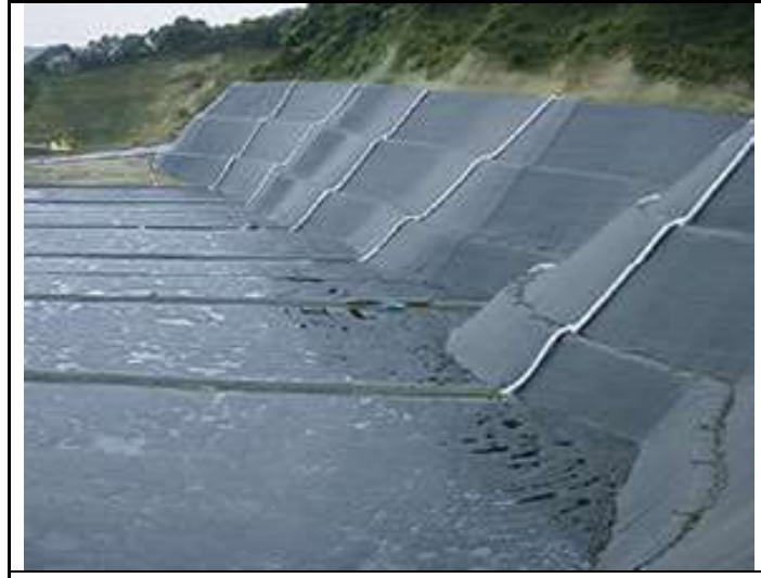
遮水シート施工後の状況
