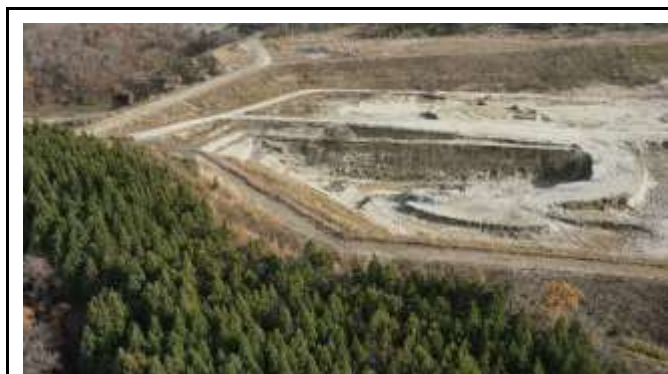
造成工事箇所
