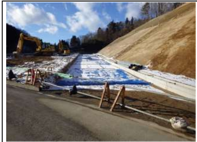
基礎地盤掘削作業の状況
