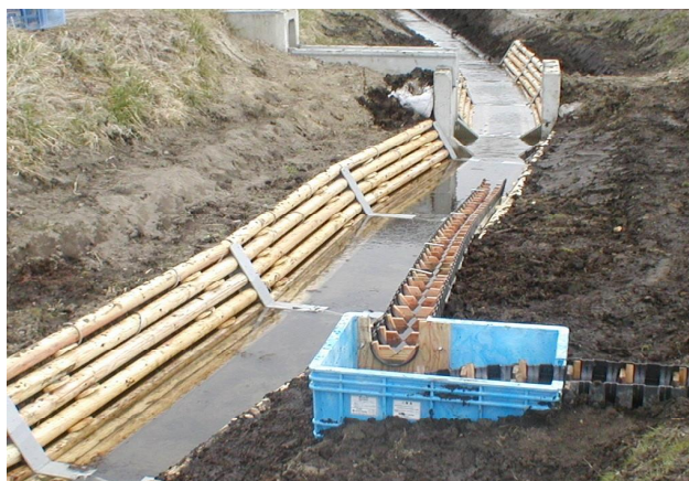
図－4 木材護岸・水田魚道の設置状況
