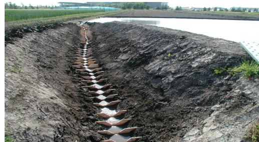
図－1 複合流路工の試作（左が木材護岸，右が水田魚道）
