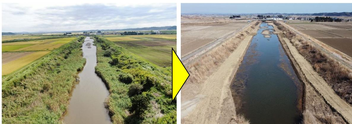
堆積土砂の撤去（高城川水系鶴田川）
