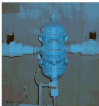
図32 薬液添加器による飲水の塩素消毒
