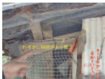
図24 ネット設置後の屋根と柱の間の隙間
