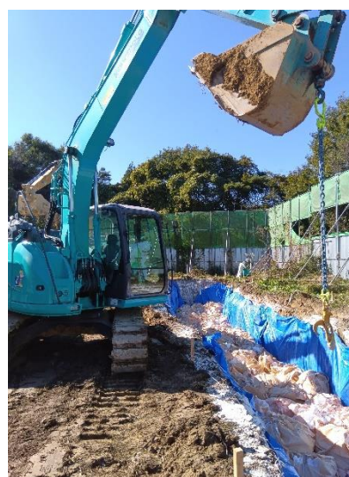
写真 4 埋却作業の様子
