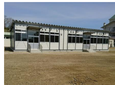
⑨ 仮設校舎の設置 (小牛田高等学園実習棟)
