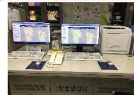
平成7年に設置した総合運動公園内全ての施設の空調設備・衛生設備の運転状況の監視、発停及び各種制御を行う中央監視装置が老朽化したため更新しました。
