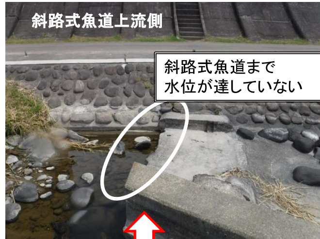
斜路式魚道上流側 斜路式魚道まで水位が達していない 渇水時は階段式、斜路式魚道に水が無い
