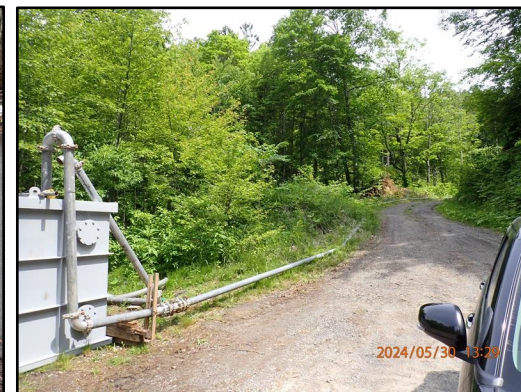
調査井掘削時における掘削用水の配管路 (左：市道沿い、右：林道沿い)
