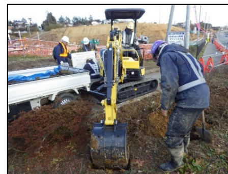
堀取り作業状況
