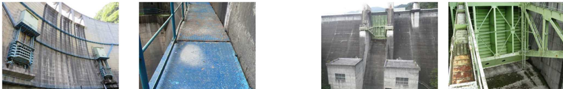
ダム管理用通路の改修(塗装)
