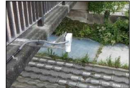
水位計の整備、改良
