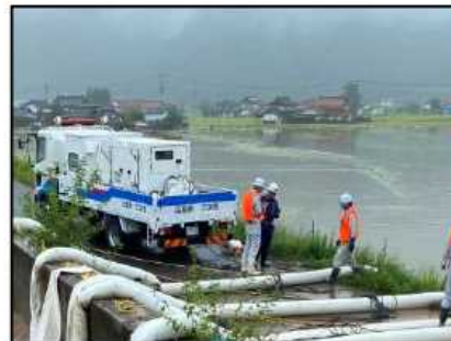
排水施設の整備
