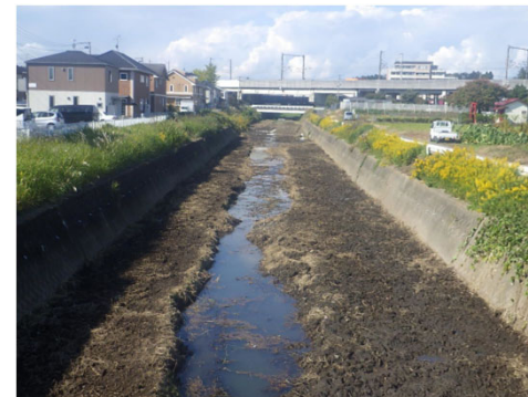
河道掘削：完成後
