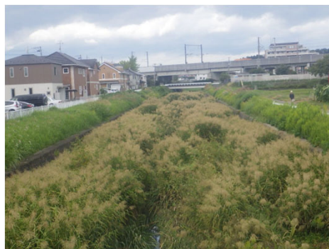
河道掘削：着手前
