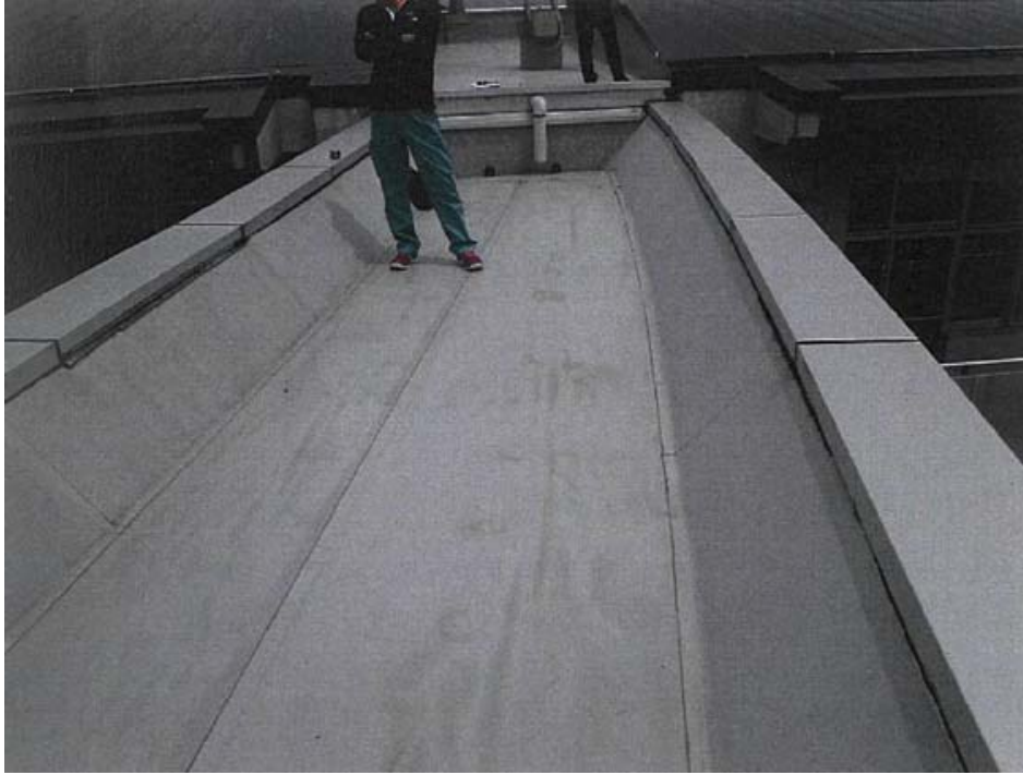
平成30年度改修設計時の調査写真
