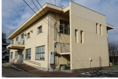
仙台保健福祉事務所岩沼支所 全景
