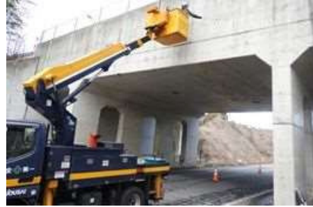
点検状況(高所作業車)
