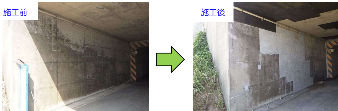
図 5-3. 断面修復工の例
