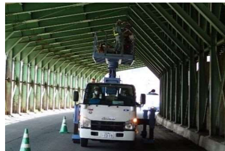
点検状況(高所作業車)
