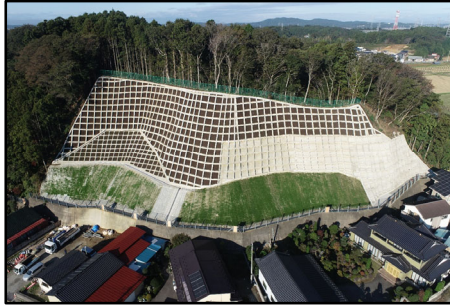
急傾斜地崩壊対策施設の整備
