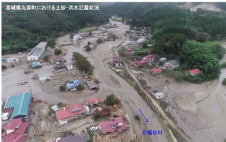
土砂・洪水氾濫被害 (令和元年東日本台風 丸森町)
