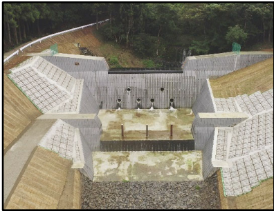
砂防堰堤の整備
