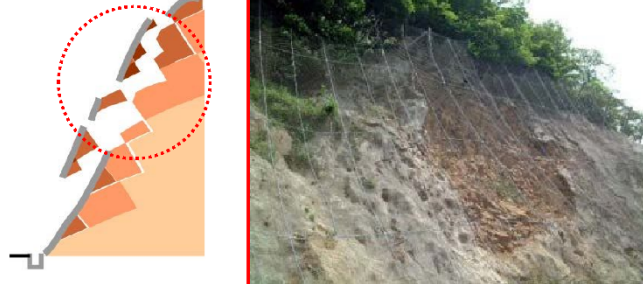
図 2.2.1(3) 吹付け法面の老朽化のメカニズム
