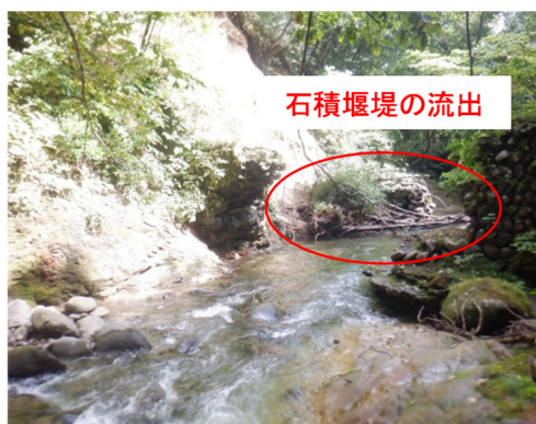
写真 2.2.1(3) 砂防えん堤の老朽化の一例
