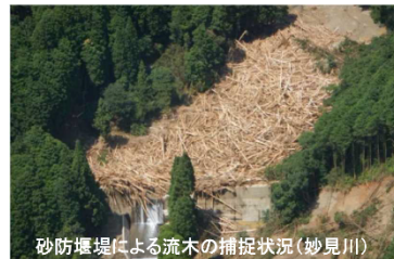
砂防堰堤による流木の捕捉状況(妙見川)
