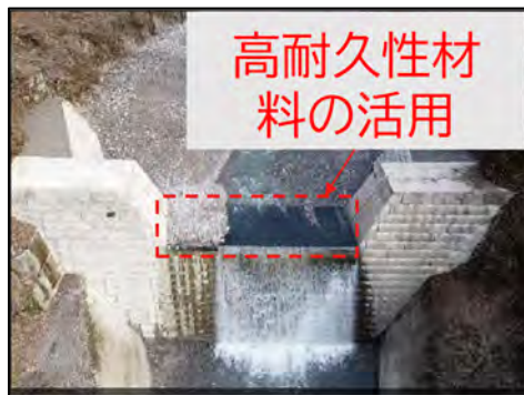
写真1 ラバーsteelによる天端摩耗の補修の例
