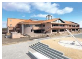
震災遺構中浜小学校 (山元町)
