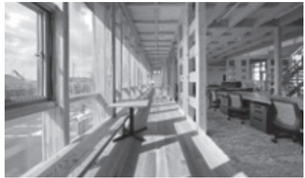
▲CLTを活用した木造社屋
