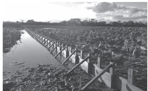
▲エコトーン造成作業の様子
