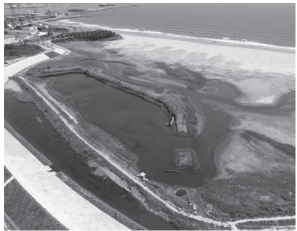
令和4年11月撮影(宮城県撮影) ▲蒲生干潟の空中写真
