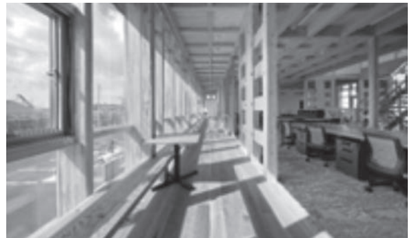
▲CLTを活用した木造社屋
