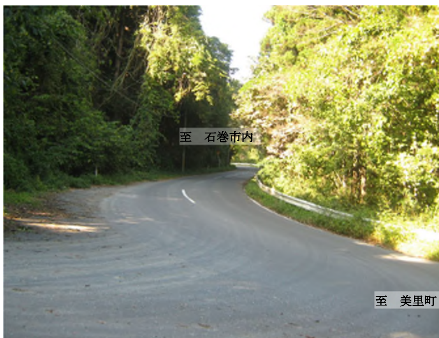
線形不良箇所
