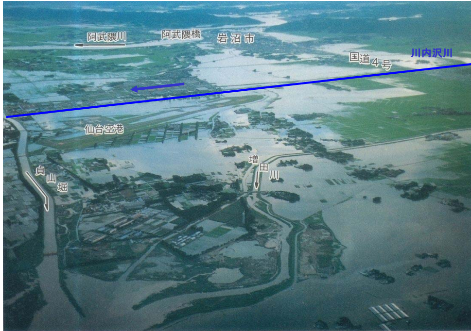
○平成6年9月22日洪水状況（川内沢川下流）
