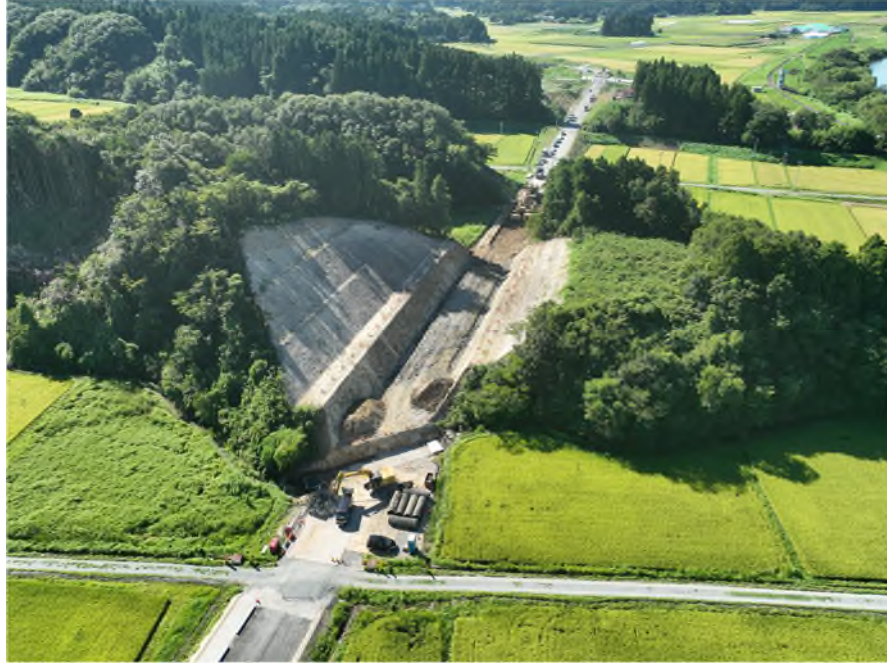
道路改良工 施工状況
