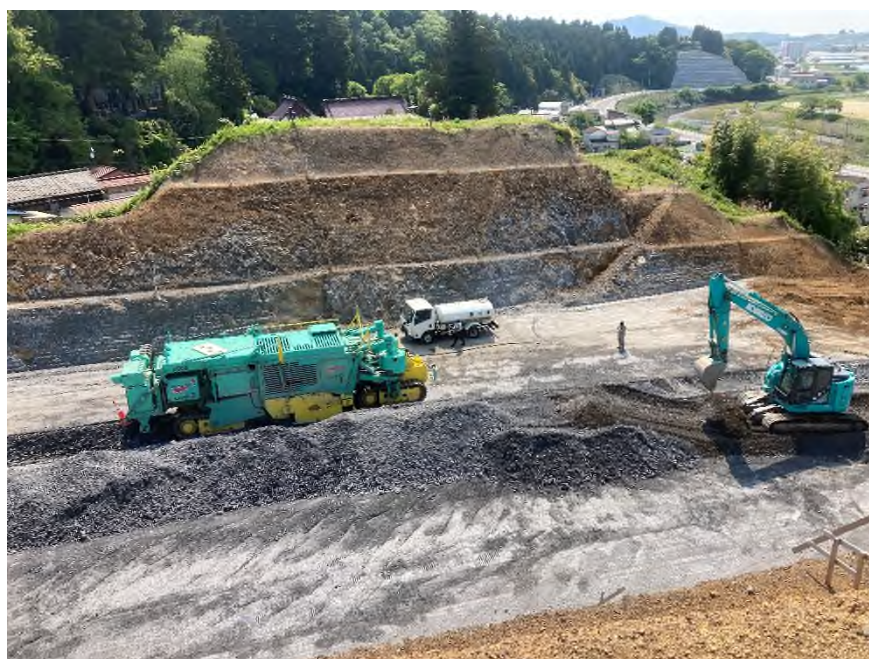
施工状況写真（岩盤切削）
