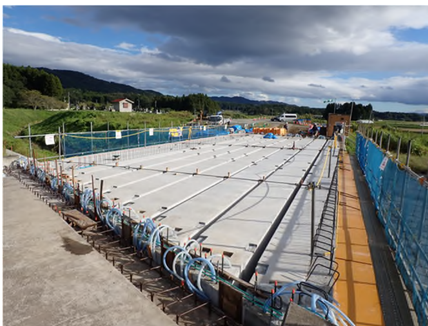
諏訪橋 施工状況
