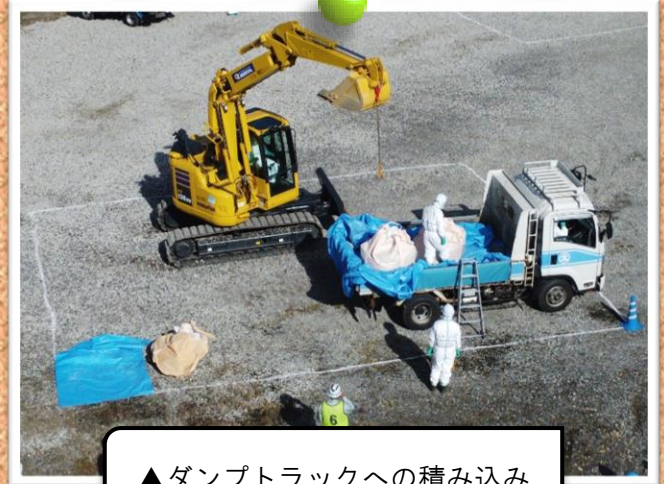
▲ダンプトラックへの積み込み
