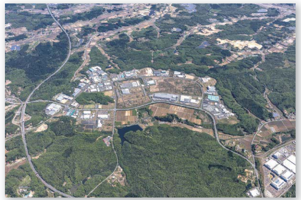
第一仙台北部中核工業団地
