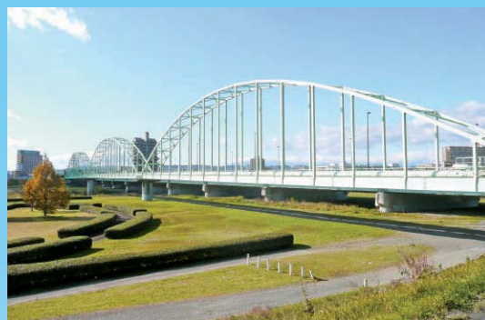
広瀬川水管橋
