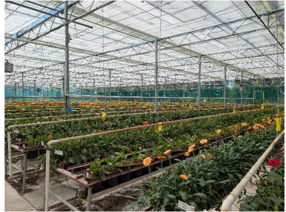
熱交換器・配水管を通じ温水をハウス内へ・室内温度を一年中一定（14℃ 以上）に保つことが可能
