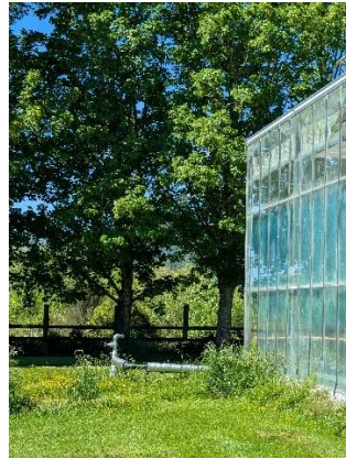
熱交換器・配水管を通じ温水をハウス内へ・室内温度を一年中一定（14℃ 以上）に保つことが可能
