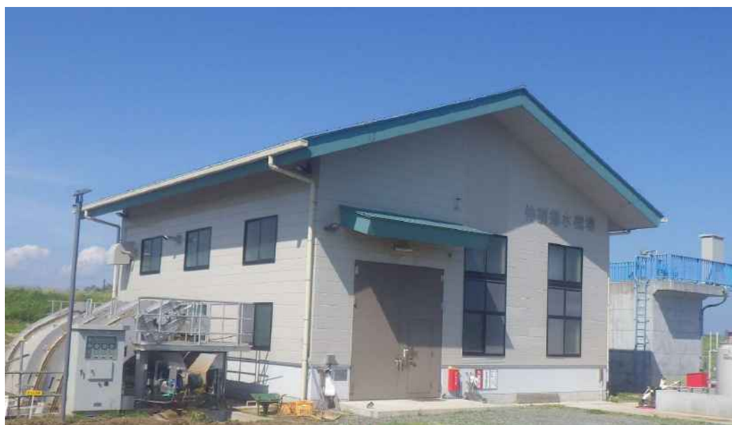
基幹的施設(伸萌排水機場)(整備後)
