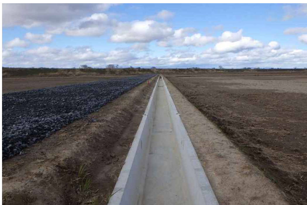
用水路工(区画整理後)
