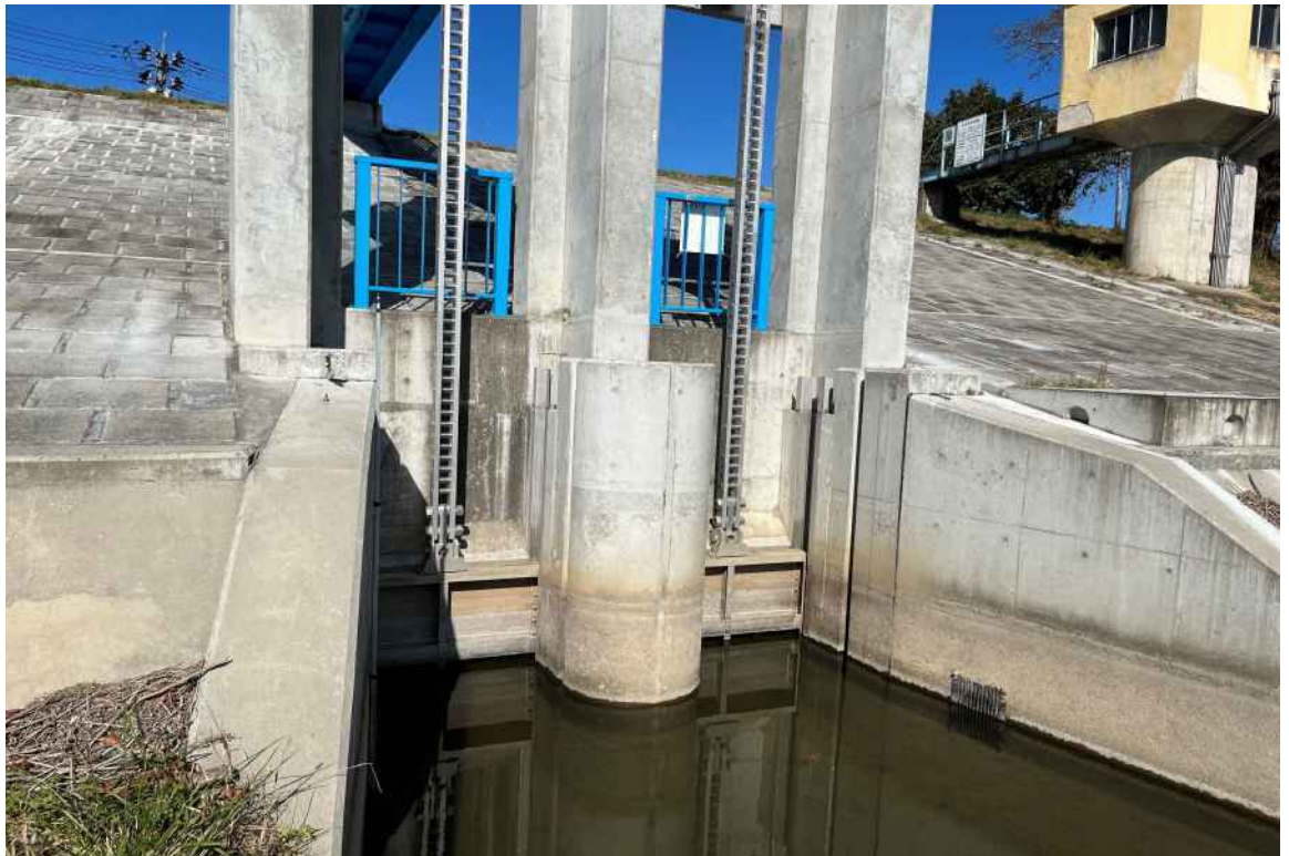
取水ゲート(整備後)
