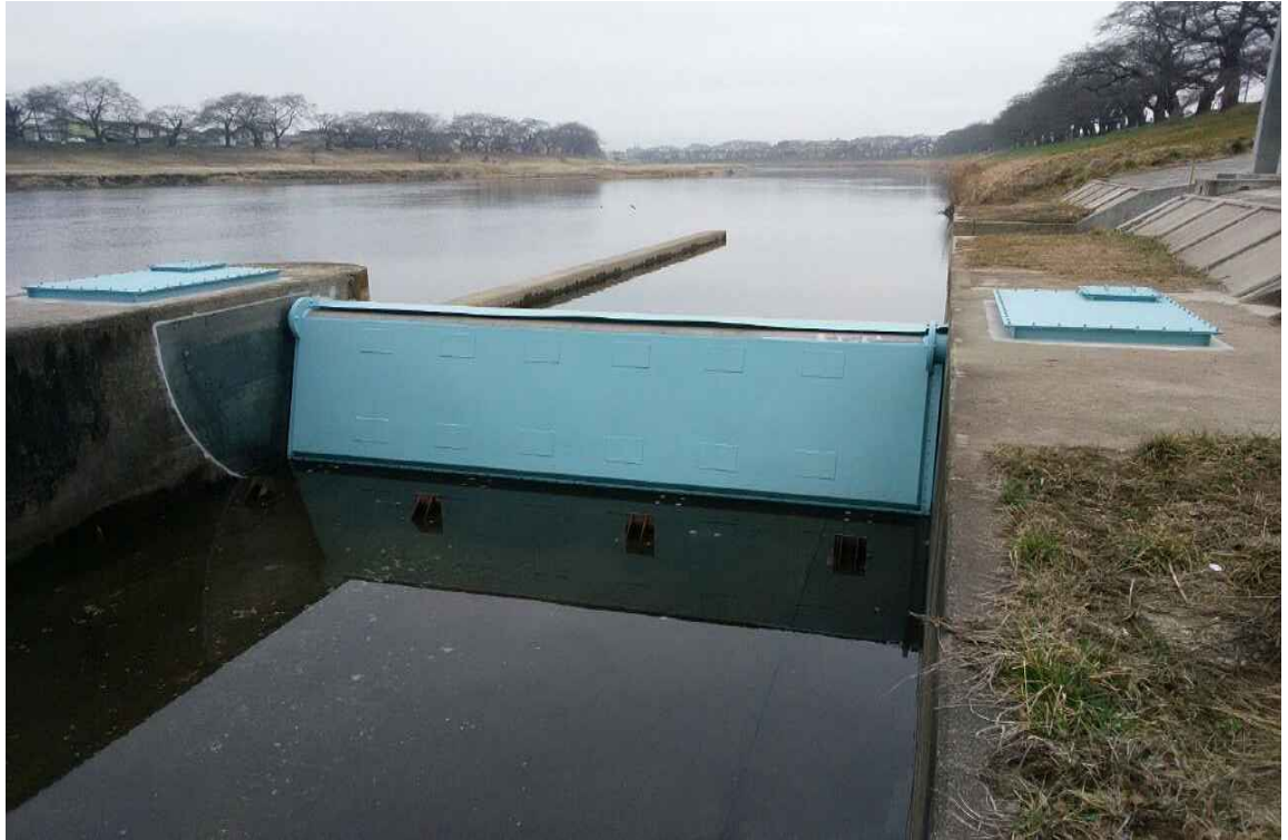
土砂吐ゲート(整備後)
