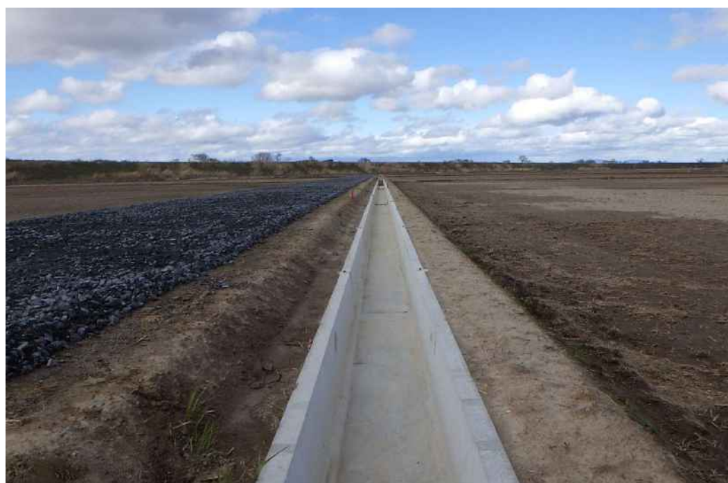
用水路工(区画整理後)
