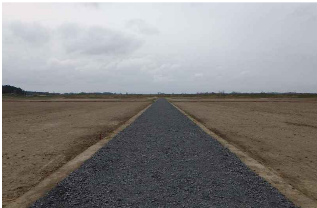
支線道路(区画整理後)
