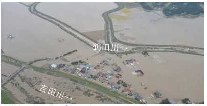
令和元年東日本台風による浸水状況
