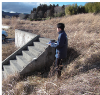
基礎撤去前の移転元地。
