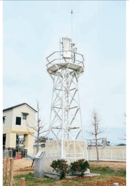
船舶を安全に導く導灯は2基(前灯・後灯)一対。航路変更に伴い平成26年に廃止された塩釜導灯は94年間夜の航路を照らし続けました。写真は前灯上部7メートル。
