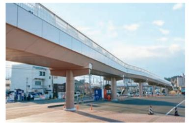
マリンゲート塩釜、さらに本塩釜駅方面を繋ぐ遊歩道「津波避難デッキ」。高さ5メートル超、長さ372メートル。
