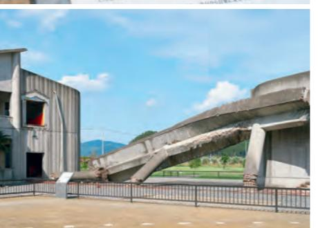
〈右上〉敷地内に設けた解説パネルとメッセージ。メッセージはかつてあった穏やかな生活を想起させ、見る人の防災意識にスポットを当てる。〈右下〉校舎の教室棟と屋内運動場をつないでいた渡り廊下部分。渦を巻いたような津波が、柱ごとねじ倒したという〈左下〉8.6mの津波に襲われた大川小学校。凸状に盛り上がった2階の床や波状痕が残る天井から、すさまじい津波の威力が伝わる。
