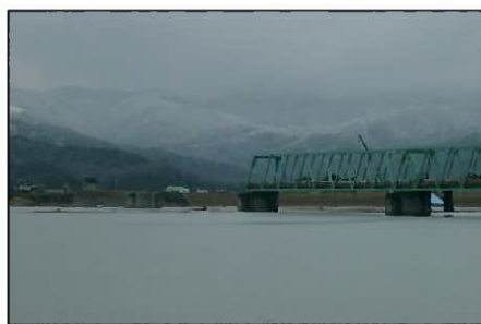
【(国)398号・新北上大橋（上部工流出）】
