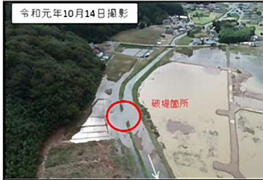
【富士川（破堤状況）】
