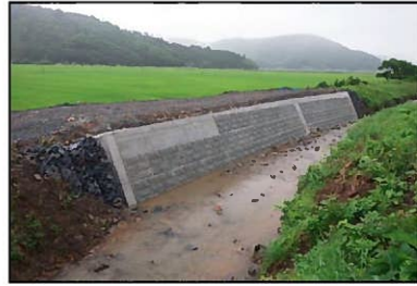
【水沼川（破堤箇所復旧）】
