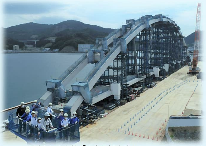
町道女川出島線「出島架橋事業」 女川小・中学校現場見学会【令和5年5月】
