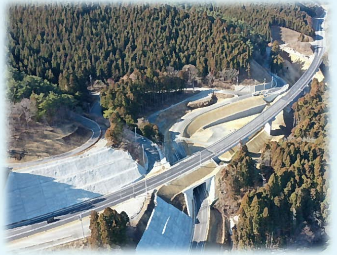
(主) 石巻鮎川線 風越2道路改良【令和5年2月全線開通】
