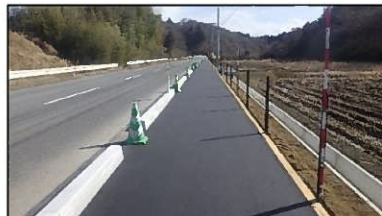
【(一)河南鳴瀬線・引沢歩道整備】
