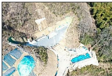
【②山崎沢1砂防堰堤整備】
