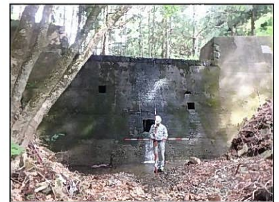
【芦早堰堤砂防メンテナンス】
