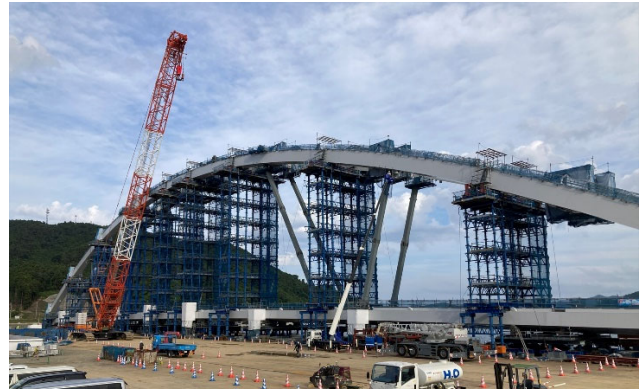
▲ 施工状況（見学会会場）
