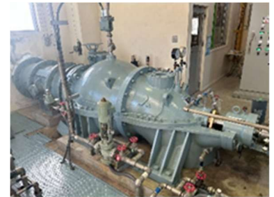
農業水利施設の更新・整備
