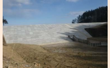
②完成（陸側から）
