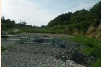
①工事着手前
