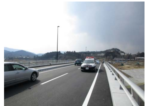
八幡橋供用状況
