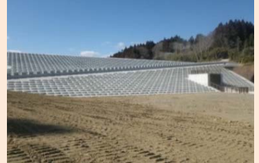
①完成（海側より）
