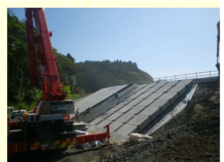
館浜地区海岸(南三陸町歌津館浜地先)
