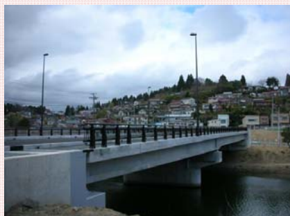
平成25年2月に供用した三代日本町橋
