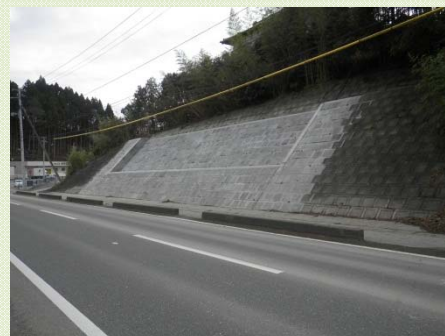
【復旧工事完了】
