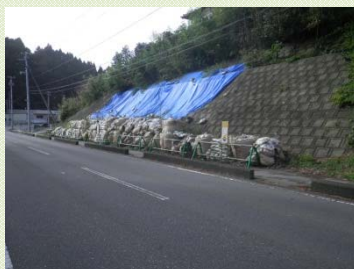
【応急工事完了後】
