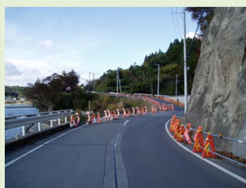
【応急工事完了後】
