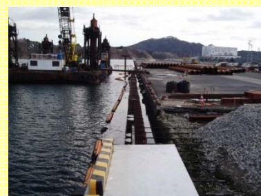
【引き続き復旧工事が進む -7.5m岸壁】
