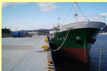
【復旧工事が完了し供用した -4.5m岸壁】
