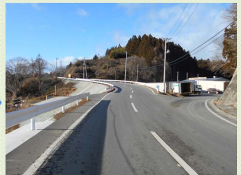
【復旧工事完了】
